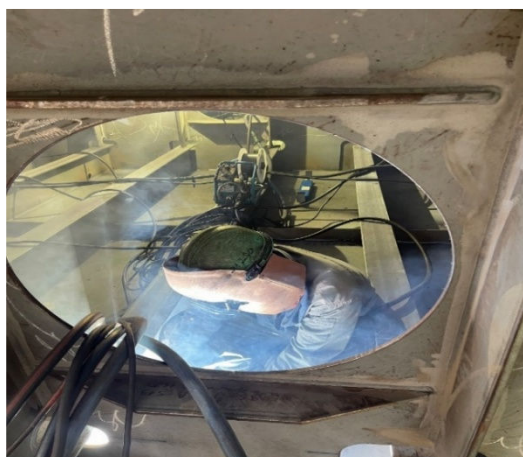
Hình 5. Công nhân hàn trong khoang máy
