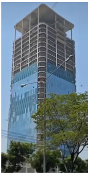
(a) Công trình lúc thi công
